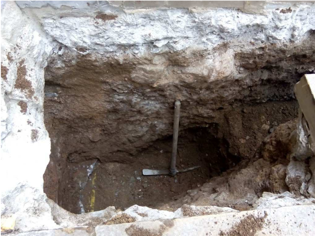
Vista del pou excavat a l'encreuament amb el carrer de la Baixada de Sant Miquel, on es pot apreciar l'estratigrafia d'anivellació tallada per la rasa de subministrament.
