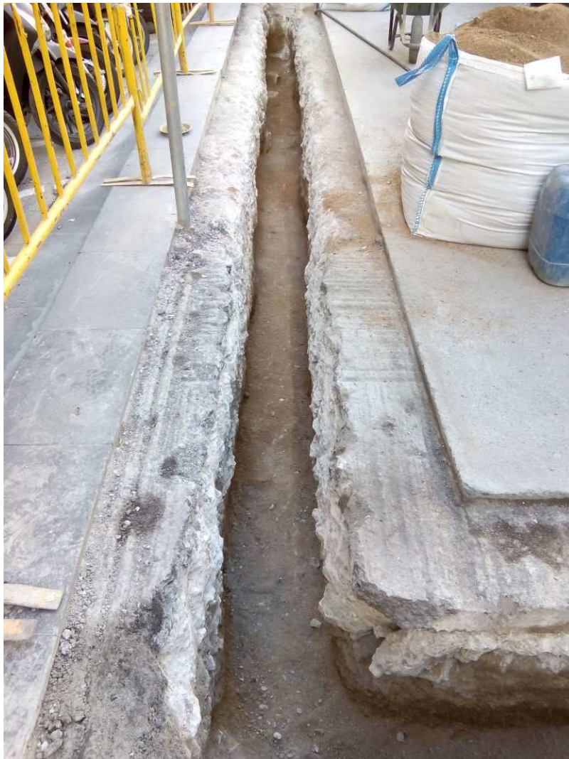
Vista de la cantonada dels trams sud-oest i sud-est.
